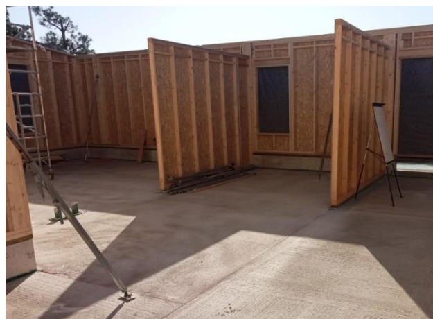
Etanchéité du bassin et coulage d'une dalle de lestage dans son fond, coulage d'une partie de la dalle béton en cours, mise en place de treillis soudés sur l'empierrement, montage des cloisons extérieures et intérieures du bâtiment, le 11 octobre 2023. Source : interne.
