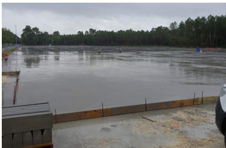
Coulage de la dernière phase de la dalle béton et ponçage de celle-ci, mise en place du système d'ANC des bureaux et mise hors d'air et hors d'eaux de ces derniers en cours, le 25 octobre. Source : interne
