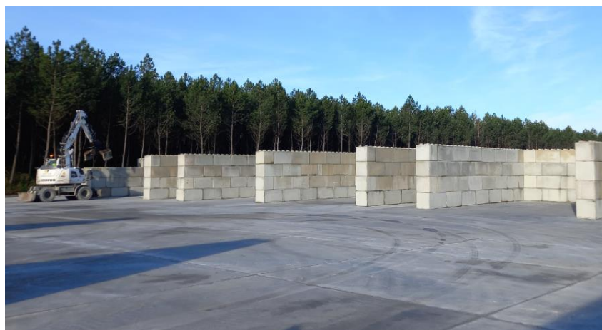
Montage des murs de blocs béton au niveau de la zone de transit et déchèterie professionnelle, réalisation du gros-œuvre de la guérite d'accueil entre les deux ponts bascules, le 6 décembre 2023. Source : interne.
