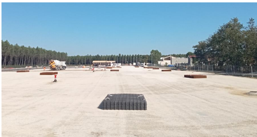
Etanchéité du bassin et coulage d'une dalle de lestage dans son fond, coulage d'une partie de la dalle béton en cours, mise en place de treillis soudés sur l'empierrement, montage des cloisons extérieures et intérieures du bâtiment, le 11 octobre 2023. Source : interne.
