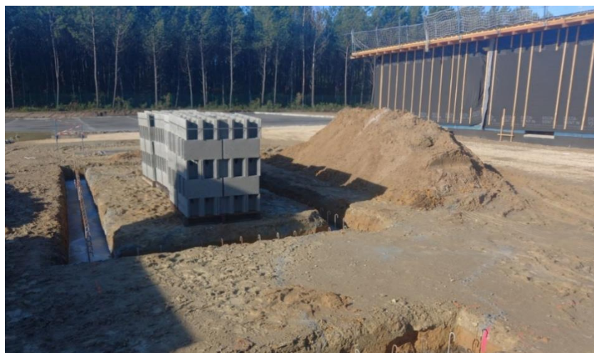
Travaux d'isolation du bâtiment de bureaux et démarrage des fondations pour la guérite d'accueil et les ponts bascules, mise en place de clôture définitives, le 8 novembre 2023. Source : interne
