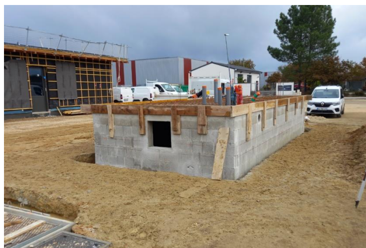
Montage des premiers murs en blocs béton, fondations de la guérite et travaux intérieurs pour les bureaux, le 22 novembre 2023. Source : interne.
