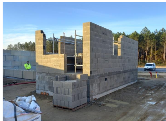
Montage des murs de blocs béton au niveau de la zone de transit et déchèterie professionnelle, réalisation du gros-œuvre de la guérite d'accueil entre les deux ponts bascules, le 6 décembre 2023. Source : interne.
