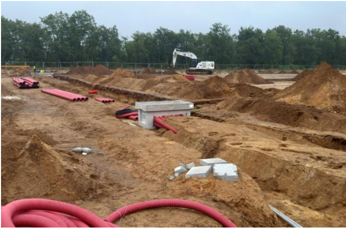
Mise en place des réseaux électriques et fondations du bâtiment, le 2 août 2023. Source : interne
