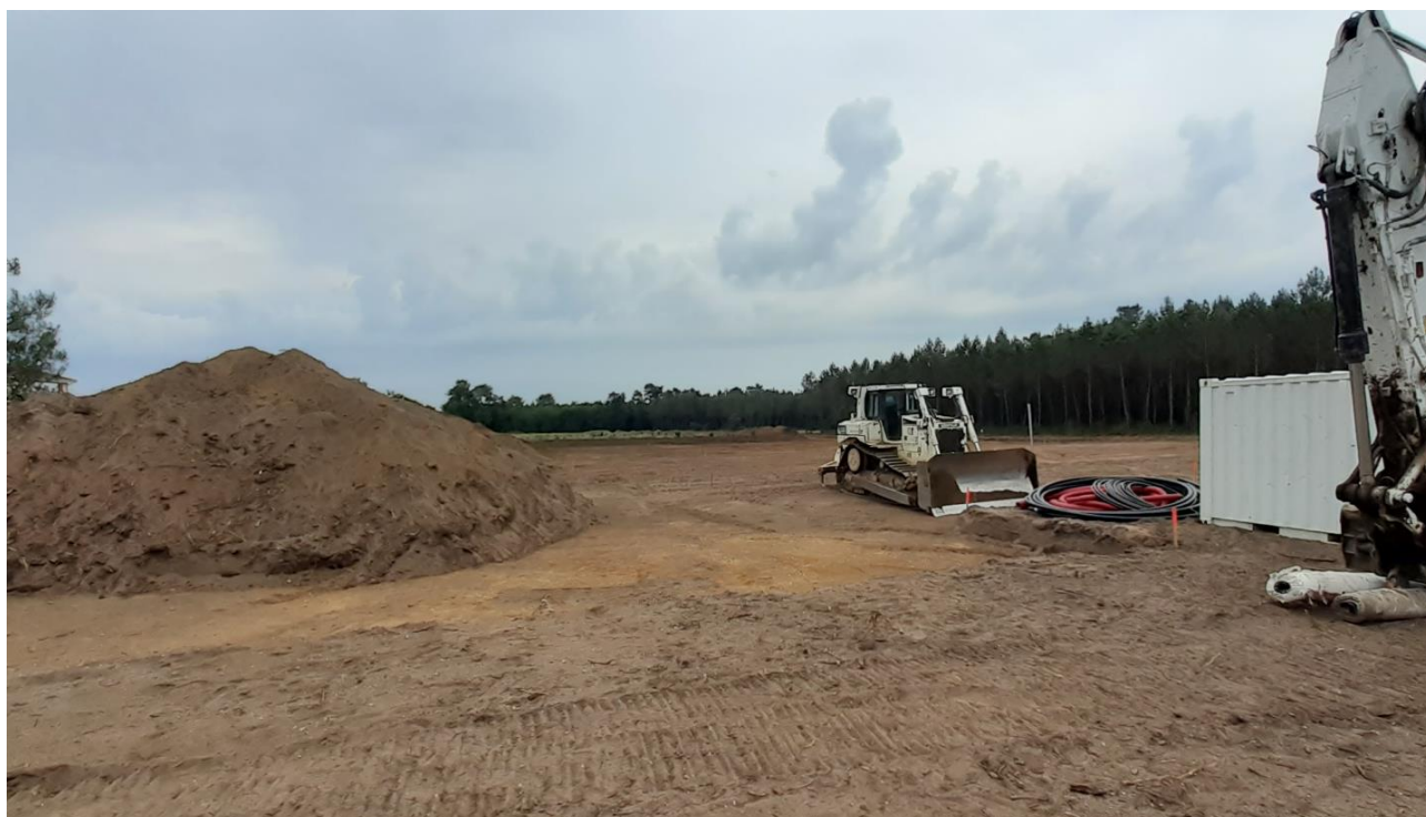
Reprise du chantier une fois le PC obtenu le 12 juin 2023. Source : interne.
