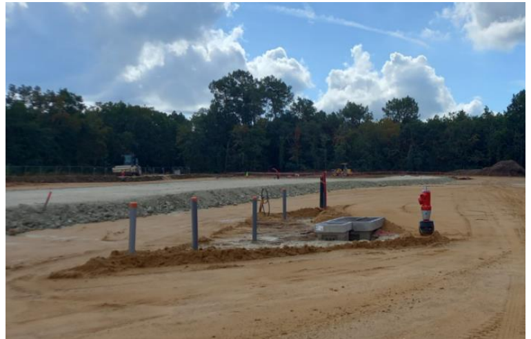
Préparation au coulage de la chape du bâtiment, finition des réseaux et démarrage de l'empierrement, le 13 septembre 2023. Source : interne
