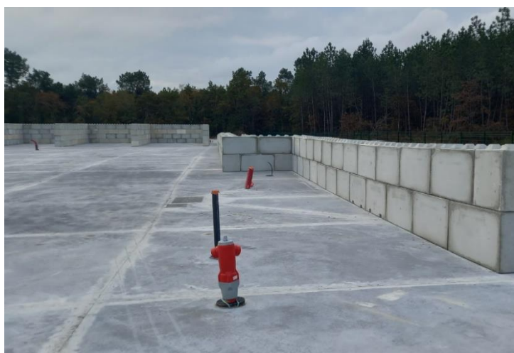
Montage des premiers murs en blocs béton, fondations de la guérite et travaux intérieurs pour les bureaux, le 22 novembre 2023. Source : interne.
