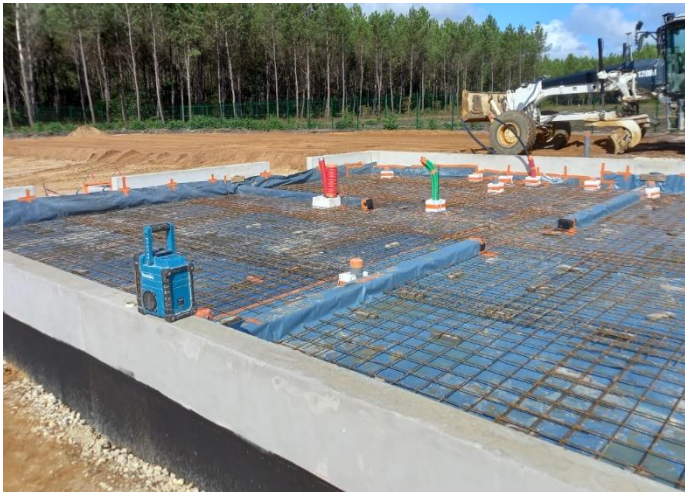
Préparation au coulage de la chape du bâtiment, finition des réseaux et démarrage de l'empierrement, le 13 septembre 2023. Source : interne
