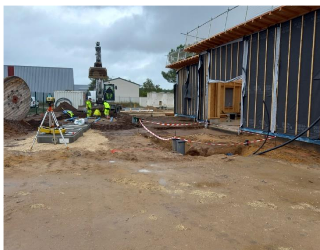
Coulage de la dernière phase de la dalle béton et ponçage de celle-ci, mise en place du système d'ANC des bureaux et mise hors d'air et hors d'eaux de ces derniers en cours, le 25 octobre. Source : interne
