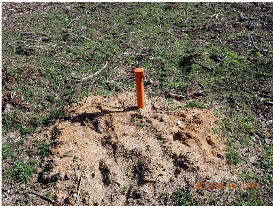
Figure 10 : piézomètre installé dans l'aire d'étude
